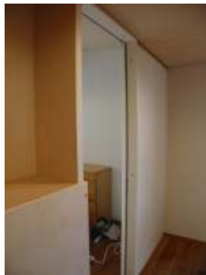
片引き戸左右2か所新設
