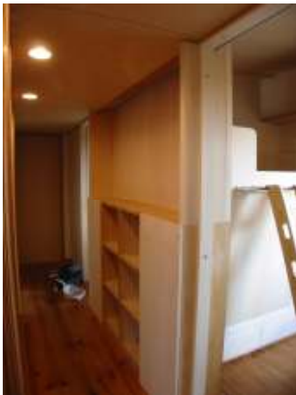
廊下と部屋の間仕切り新設
