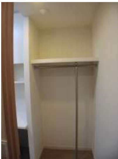
クローゼットの扉を反対側に移設し、2階側の入口に
