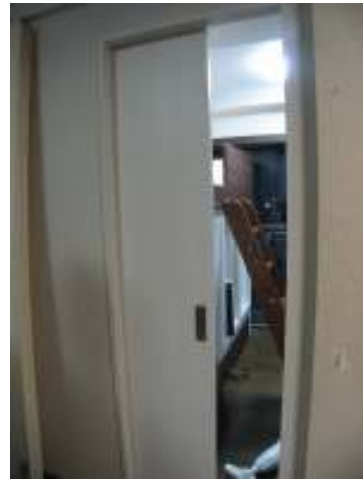
リビングから見た片引戸新設
