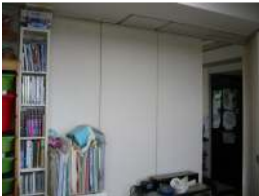
リビング側の間仕切りパネルの左を撤去(既存の写真)
