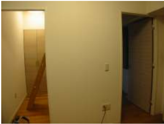
左の開口部はリビングの間仕切を穴あけ
