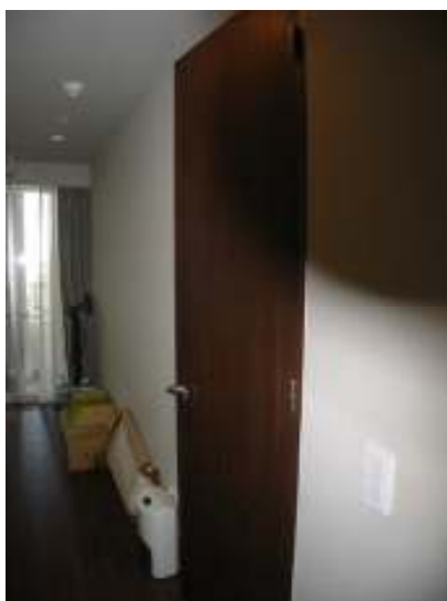
隣室の壁に片開ドアを設置し2階側の入口
