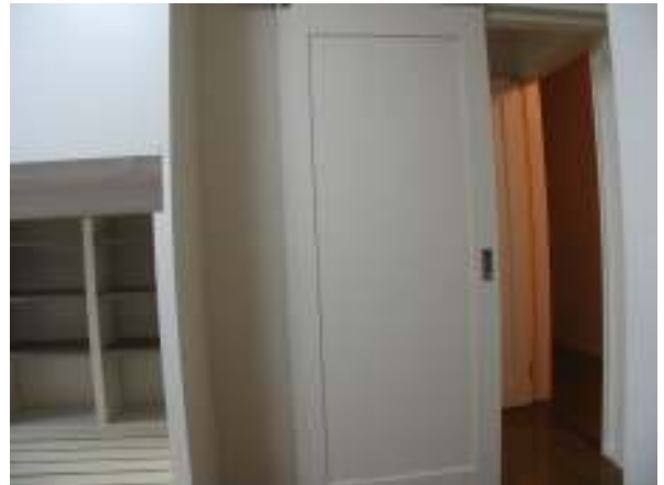
1階側室内に片引き戸を新設
