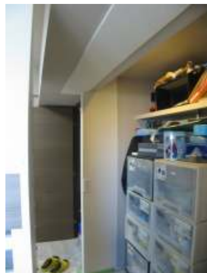
クローゼットの袖壁撤去
