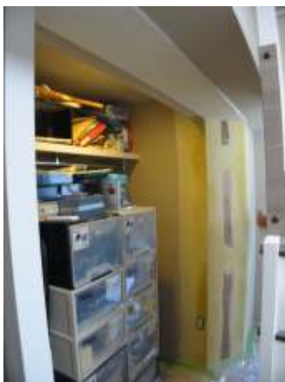
クローゼットの扉と枠と角を撤去して通路を確保
