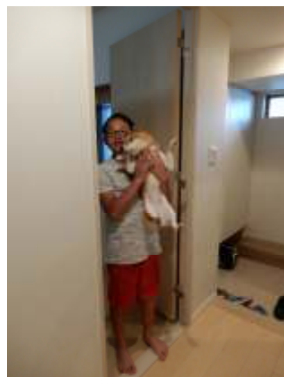
玄関手前に片開きドア新設
