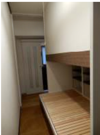
1階ベッド、正面の引き戸は新設
