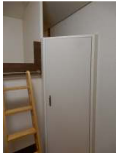
入口はドア撤去して左右に片開戸新設
