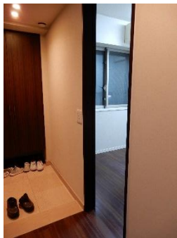
玄関脇に片引き戸を新設
