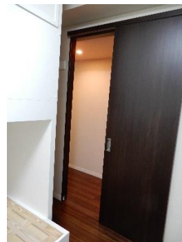
室内から新設片引き戸を見る
