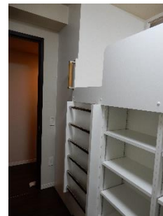
2 階ベッド側から既存片開き戸を見る
