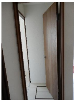
クロゼットの横に片開戸を新設
