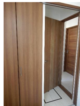
室内から新設片開き戸を見る
